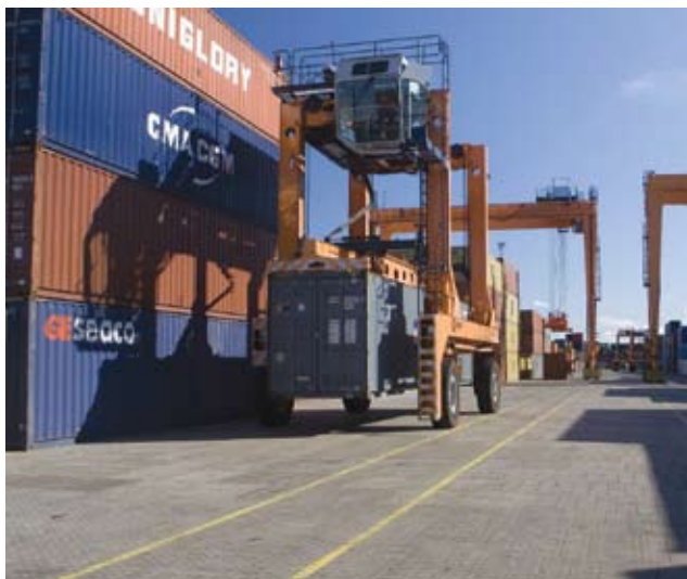
Рис. 13. Дорожное покрытие из искусственных камней мощения на контейнерных терминалах.
