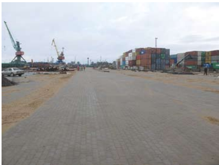
Рис. 13. Дорожное покрытие из искусственных камней мощения на контейнерных терминалах.
