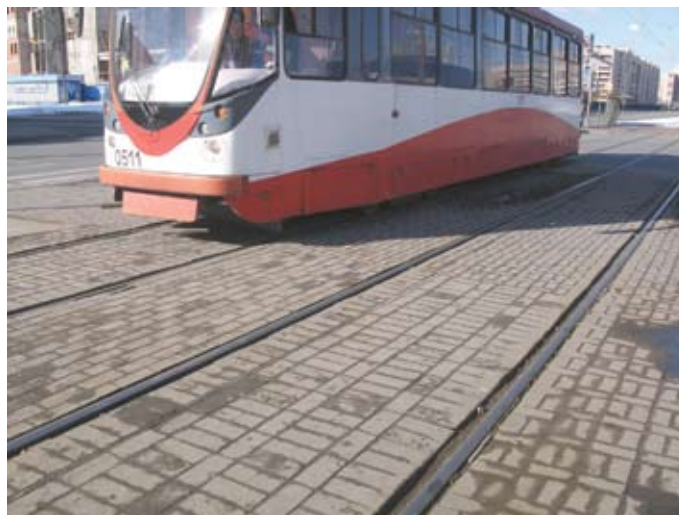
Рис. 36. Общий вид трамвайных путей вымощенных искусственным камнем “Брусчатка”.
