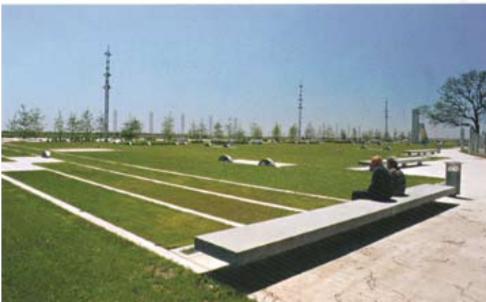
Укладка бетонной плитки с разрывами для заполнения травой
