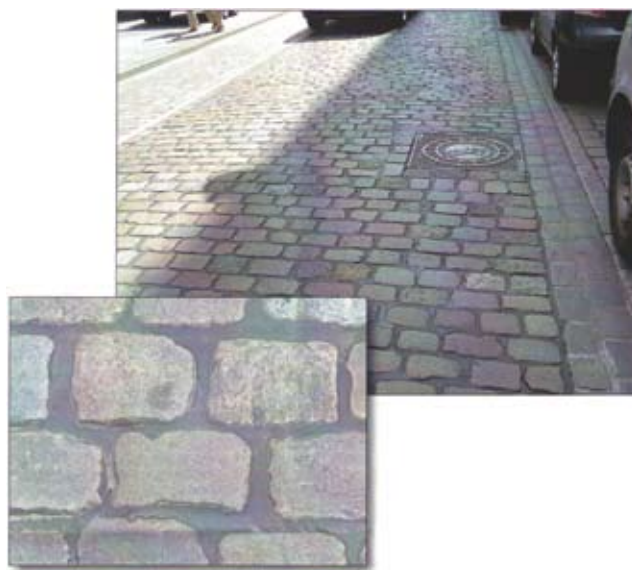
Рис. 24. Дорожное покрытие из мелкоштучных элементов с заполнением швов битумной мастикой. Мостовая в Бремене (Германия). Фото Радовского Б.С.
