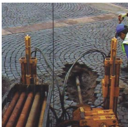
Рис. 1. Дорожные покрытия из мелкоштучных элементов мощения разбираются и восстанавливаются обратно при ремонте и прокладке подземных коммуникаций.
