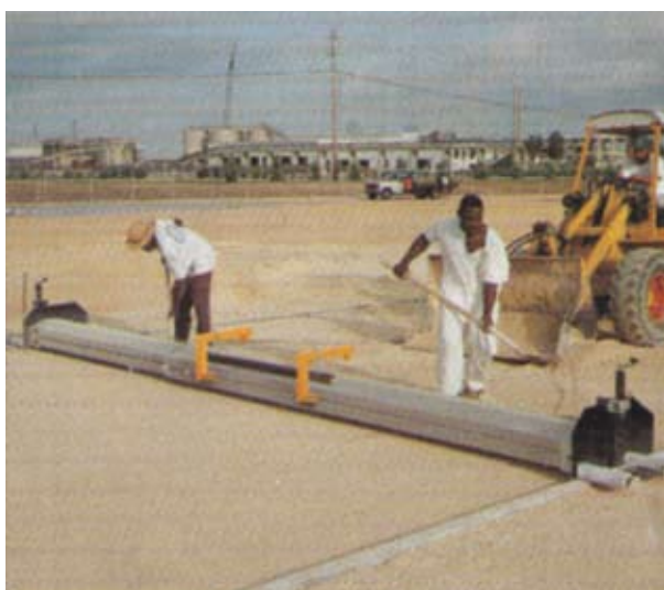
Рис. 40. Планировочный рубанок “PROBST” для подготовки монтажного слоя перед укладкой камней мощения.
