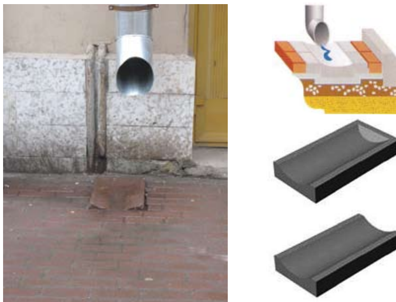
Рис. 23. Пример установки водосборных лотков (500 x 250 x 80 мм) под водосточные трубы.
