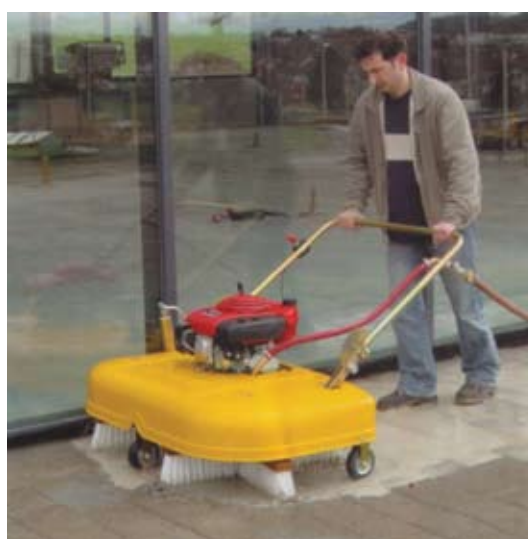
Рис. 41. Метущие щётки “PROBST” для заполнения швов между камнями.
