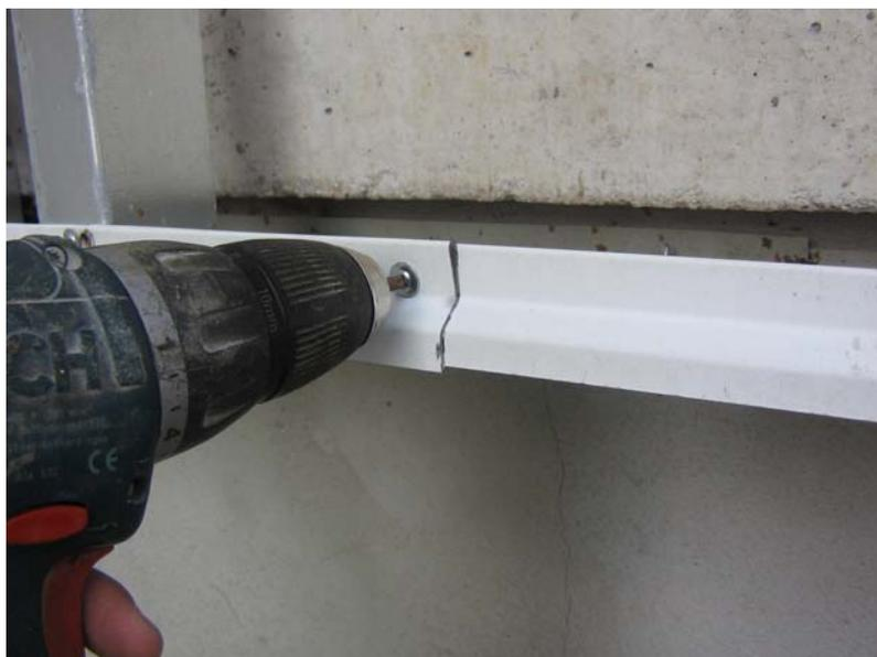
*Рисунок 4. Установка начальной планки*
