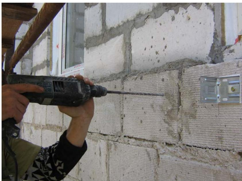
*Рисунок 1. Сверление отверстий при помощи электродрели*
