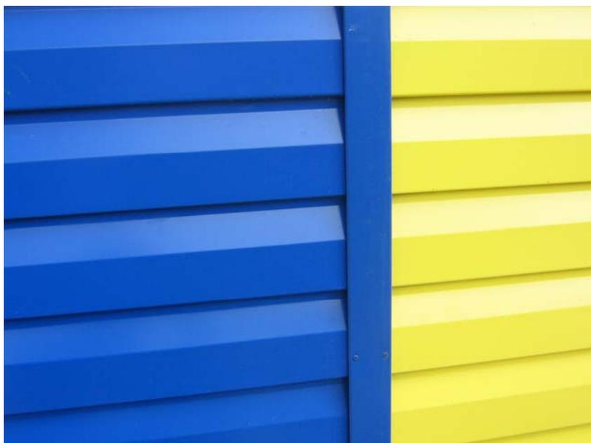
*Рисунок 9. Стыковочный элемент*
