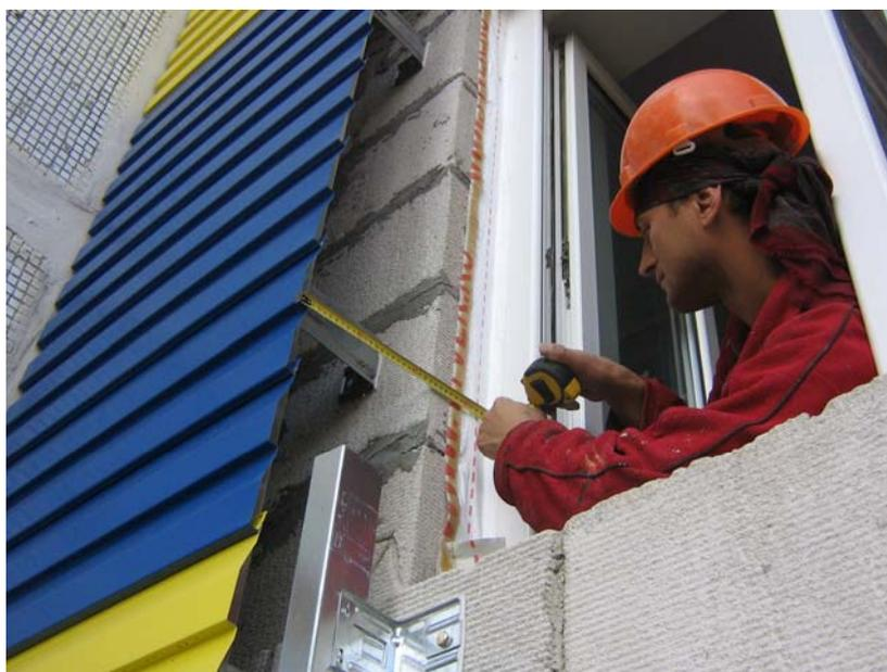
*Рисунок 8. Разметка места крепления планки откоса*
