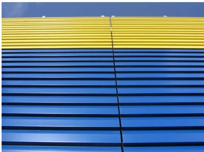
*Рисунок 7. Стыковка с зазором*
