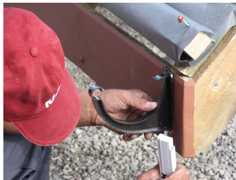
Рис. 50. Установка маяковых (крайних) кронштейнов
