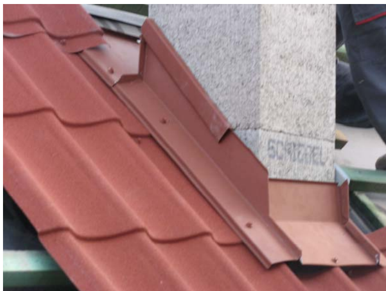
Рис. 71. Устройство защитно-декоративной полосы
