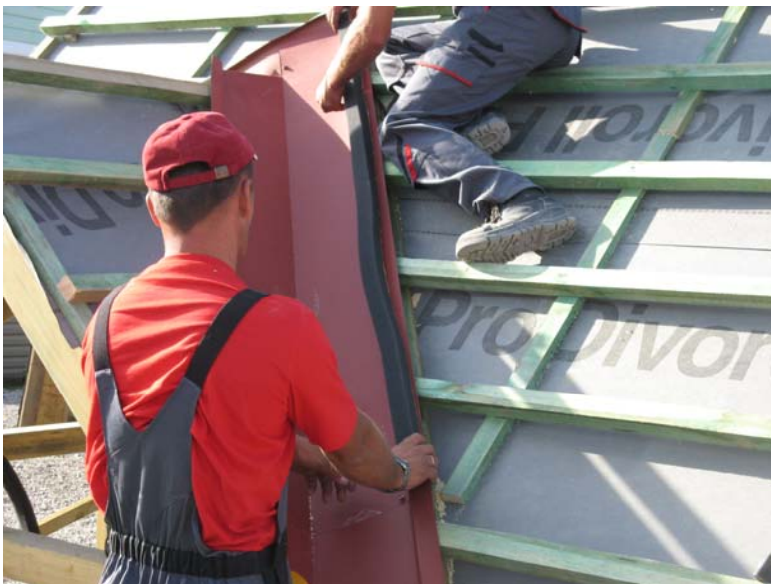
Рис.16. Устройство планки на ендове
