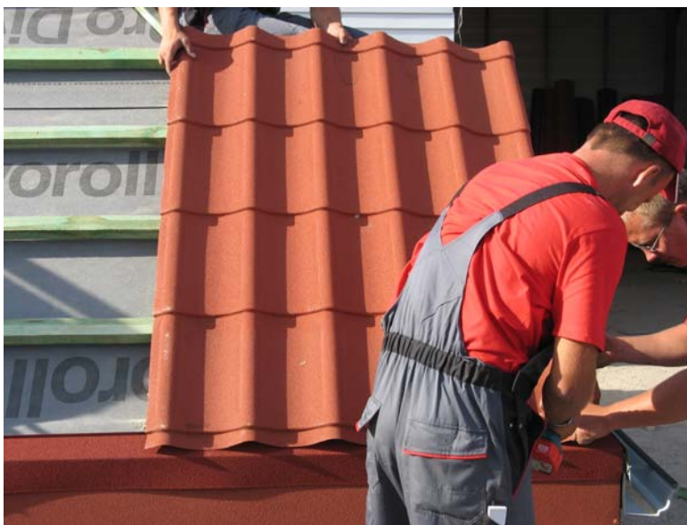
Рис.25. Монтаж первого листа металлочерепицы
