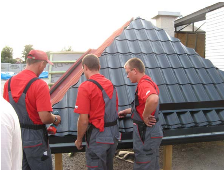
Рис. 62. Расположение планки снегоуловителя вдоль линии карниза ската
