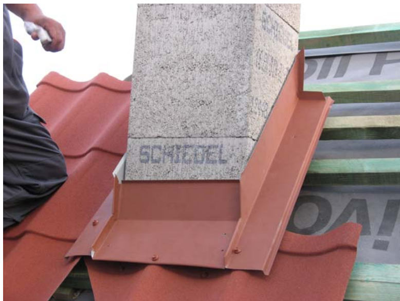
Рис. 67. Монтаж боковых планок фартука
