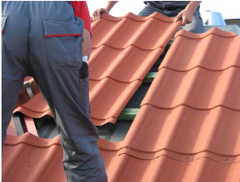
Рис.33. Укладка листа металлочерепицы в проектное положение
