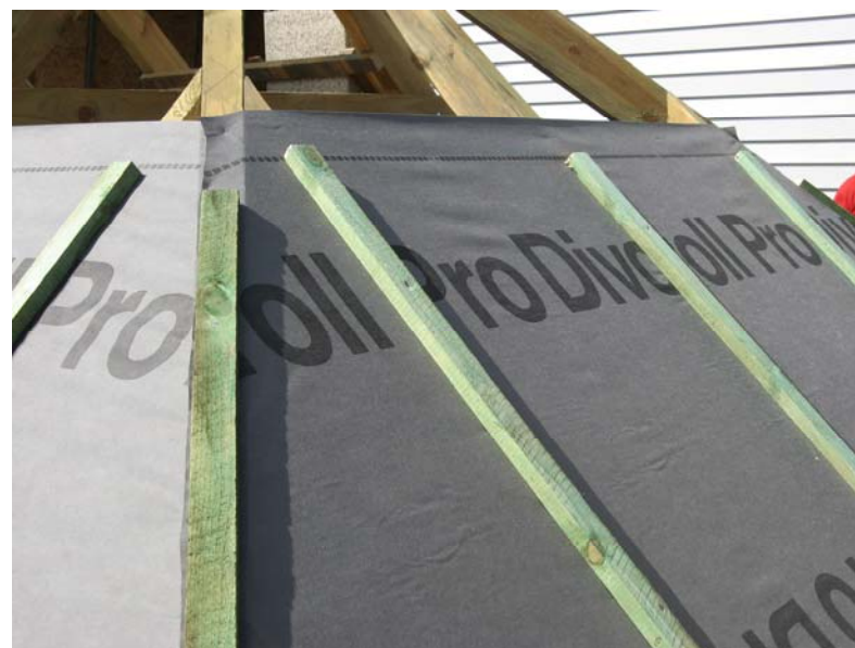
Рис.11. Устройство контрреек
