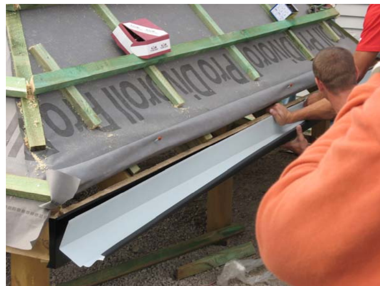
Рис. 57. Размещение планки желоба на лобовой доске
