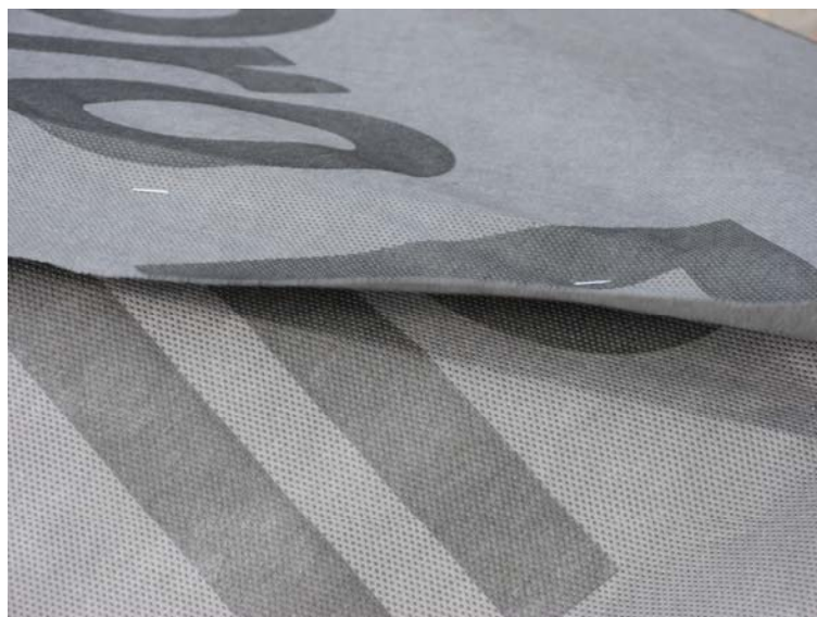
Рис.10. Соединение смежных полотнищ мембраны на стропилах
