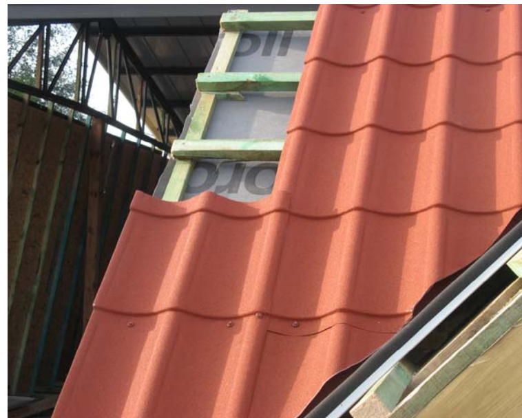
Рис.37. Проектное расположение последнего листа на скате
