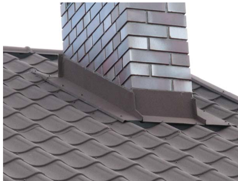
Рис. 72. Вид слева на дымоход с планками фартука
