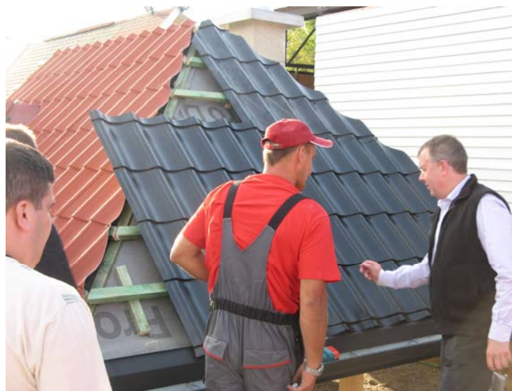
Рис.41. Расположение листов металлочерепицы на смежных скатах
