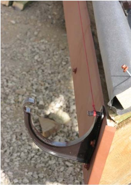
Рис. 51. Установка промежуточных кронштейнов
