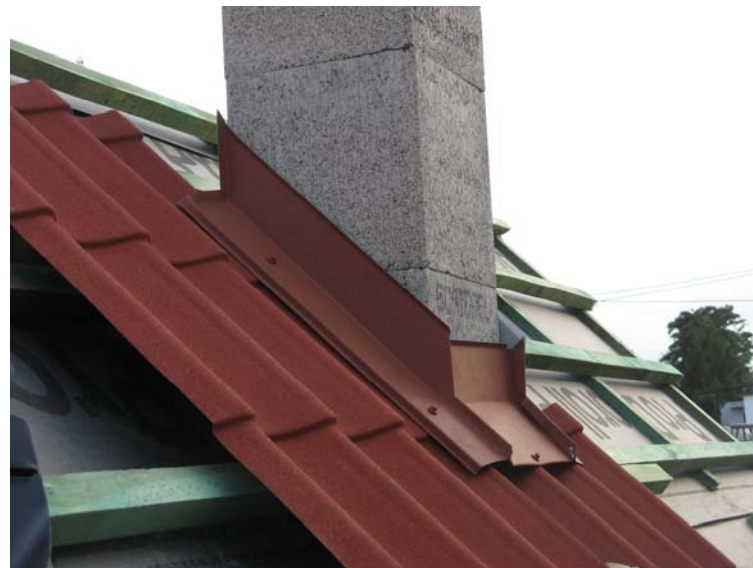
Рис. 68. Расположение боковых и нижней планок фартука
