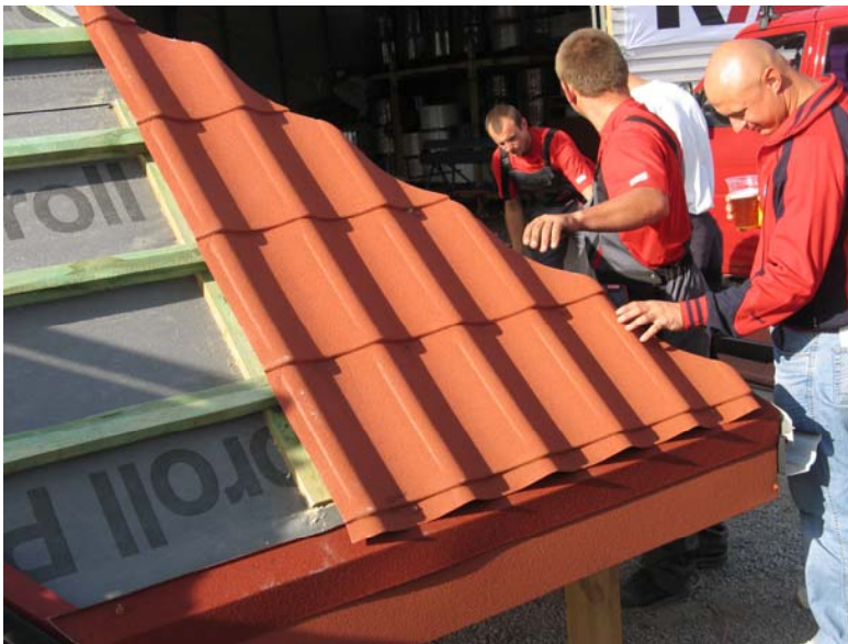
Рис.29. Окончательное закрепление первого листа металлочерепицы
