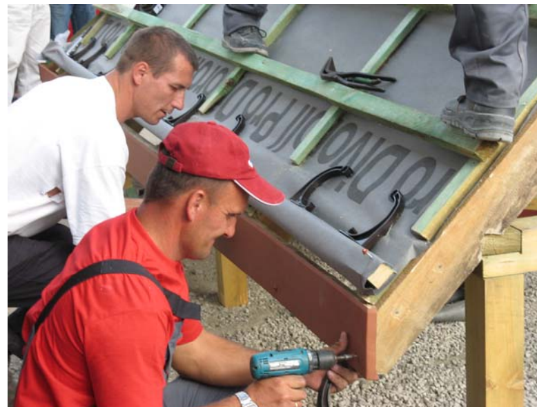
Рис. 49. Подготовка лобовой доски
