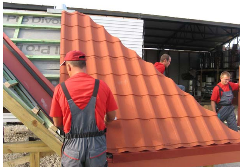
Рис.31. Монтаж второго листа металлочерепицы
