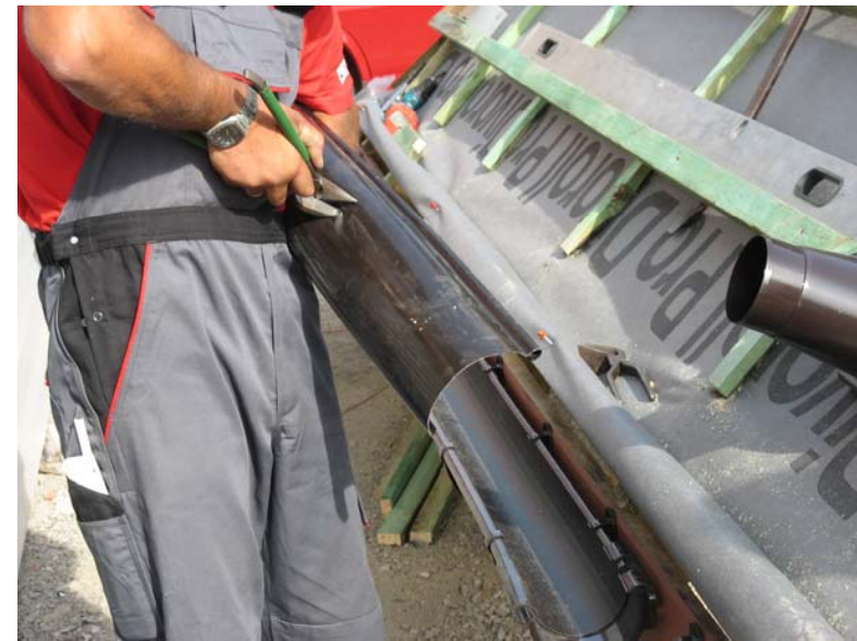
Рис. 54. Вырезание отверстия в желобе для водостока
