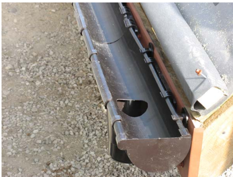
Рис. 55. Заглушка на конце желоба
