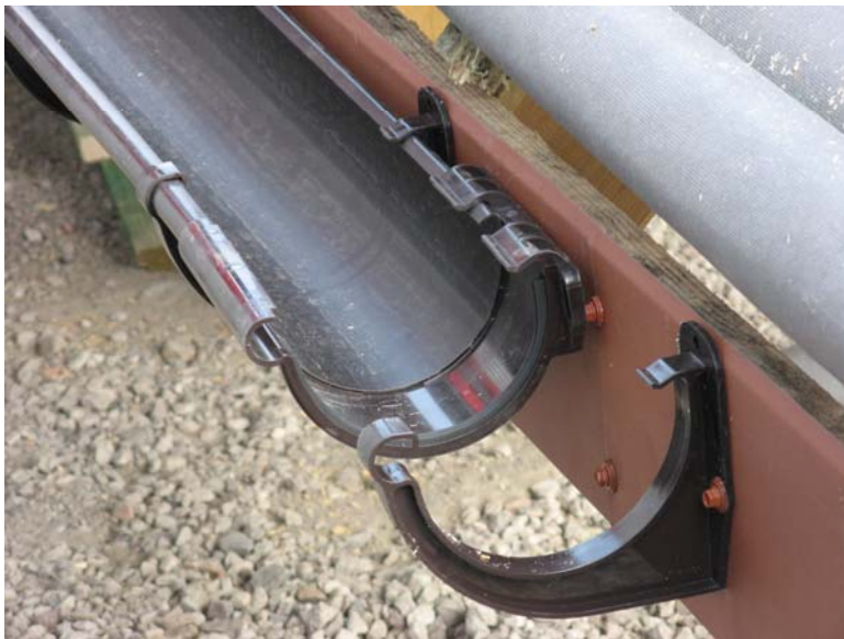
Рис. 52. Установка желобов в кронштейны
