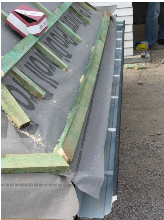
Рис. 59. Выпуск супердиффузионной мембраны в желоб
