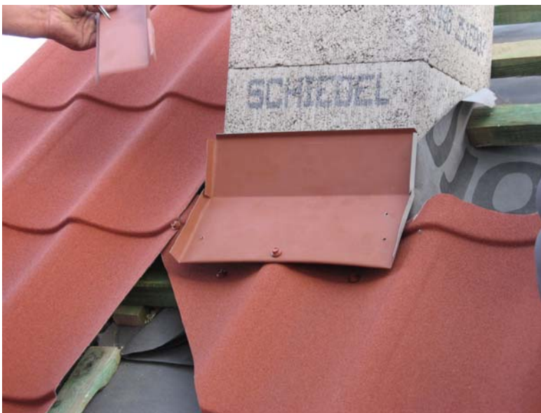
Рис. 65. Монтаж нижней планки фартука
