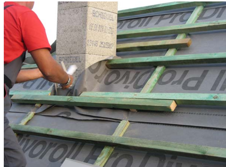
Рис. 63. Общий вид дымохода
