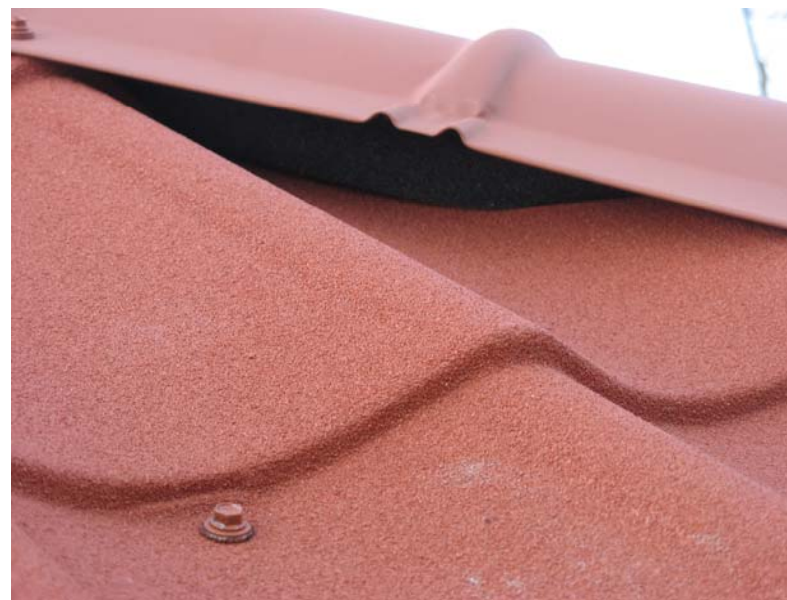
Рис.44. Герметизация подкровельного пространства возле конька
