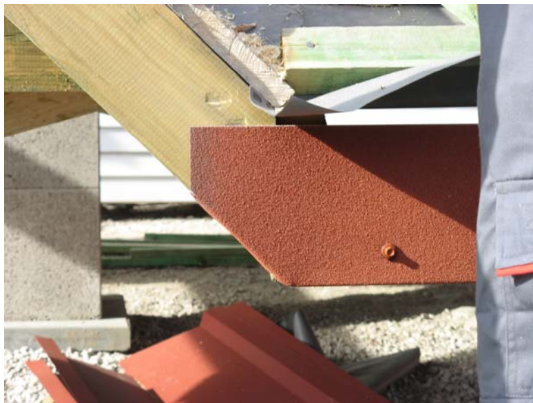
Рис.20. Размещение планки зашивки лобовой доски карниза
