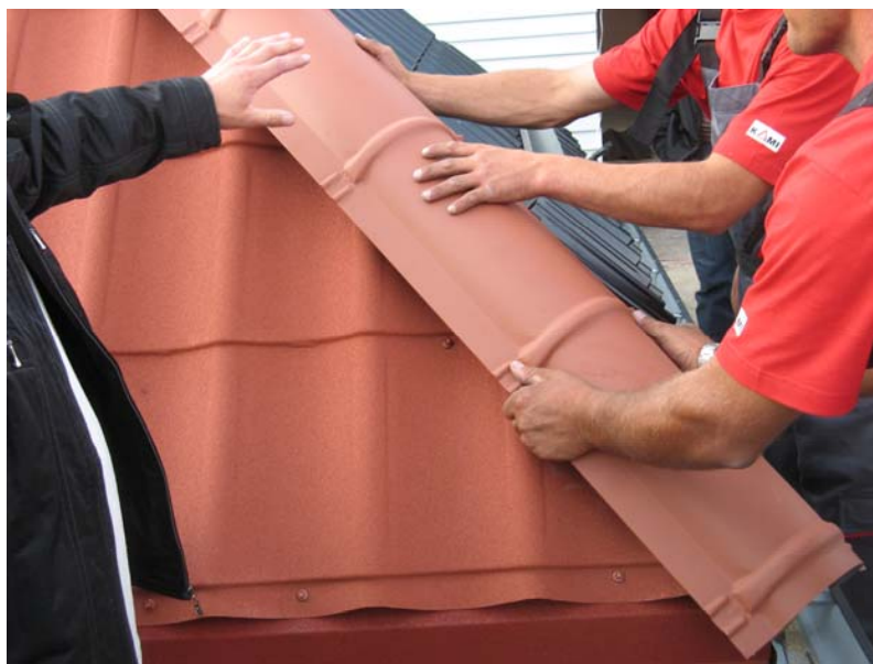
Рис.43. Монтаж планки конька
