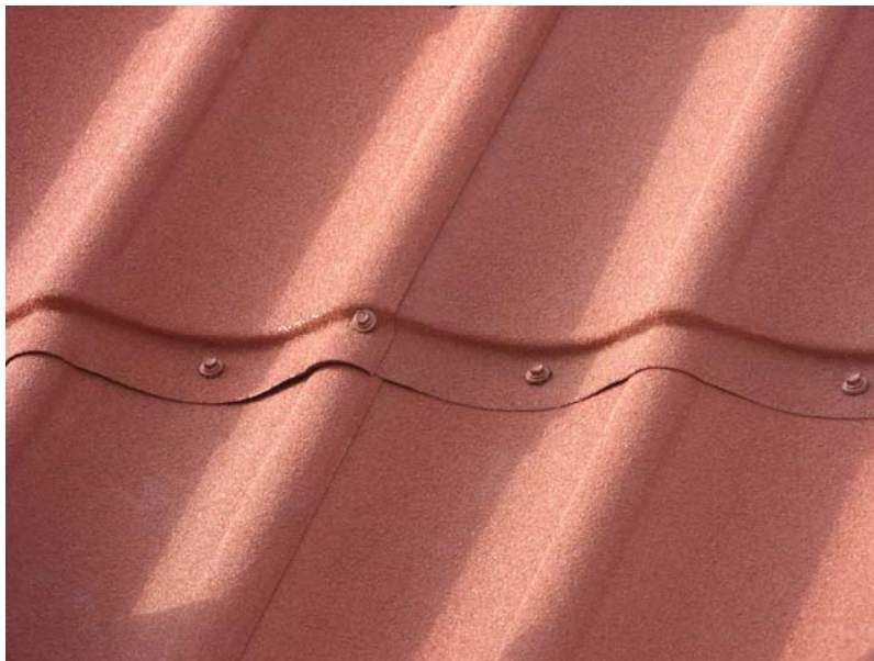
Рис.36. Окончательное крепление
