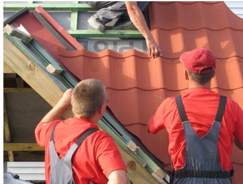
Рис.32. Монтаж третьего листа металлочерепицы
