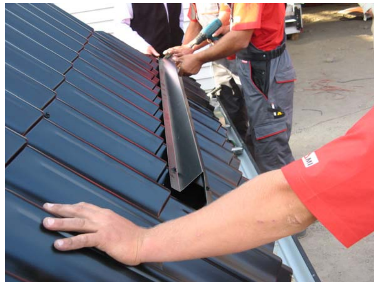
Рис. 60. Расположение планки снегоуловителя на скате
