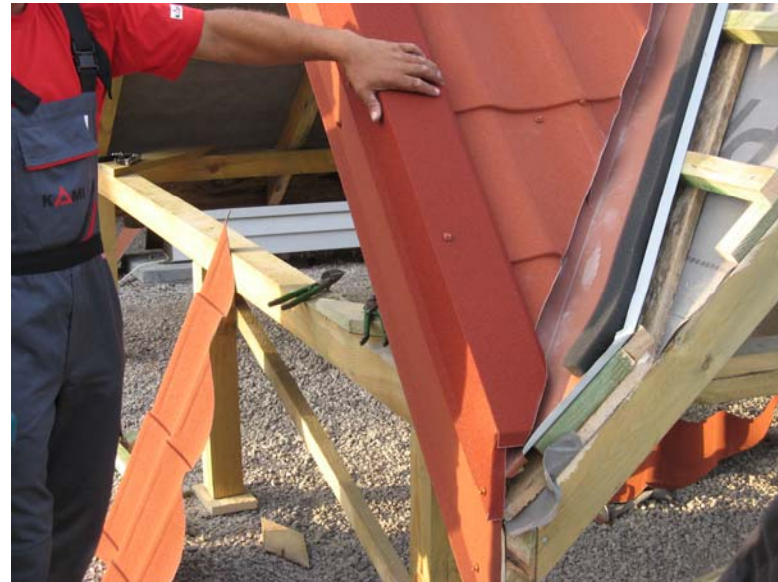
Рис.47. Монтаж планки ветрозащиты
