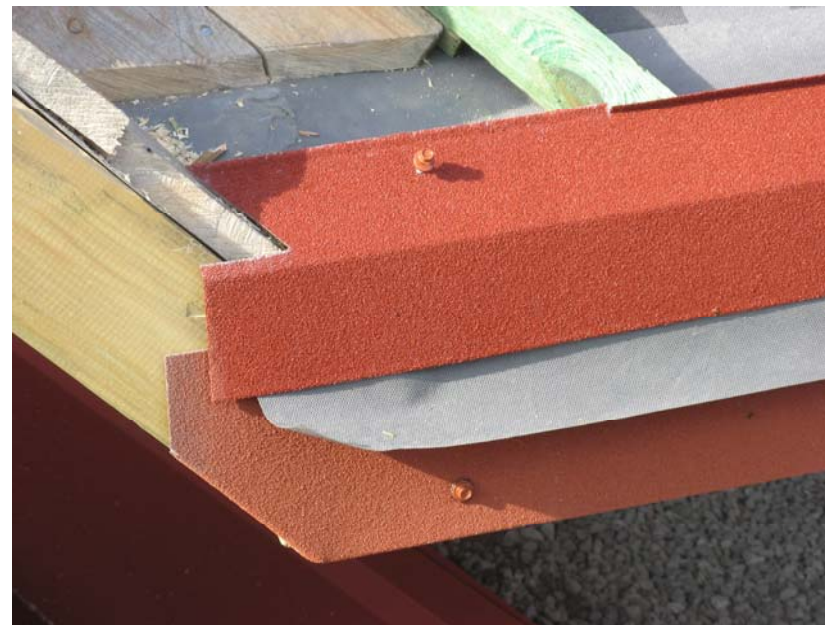
Рис.21. Размещение карнизной планки
