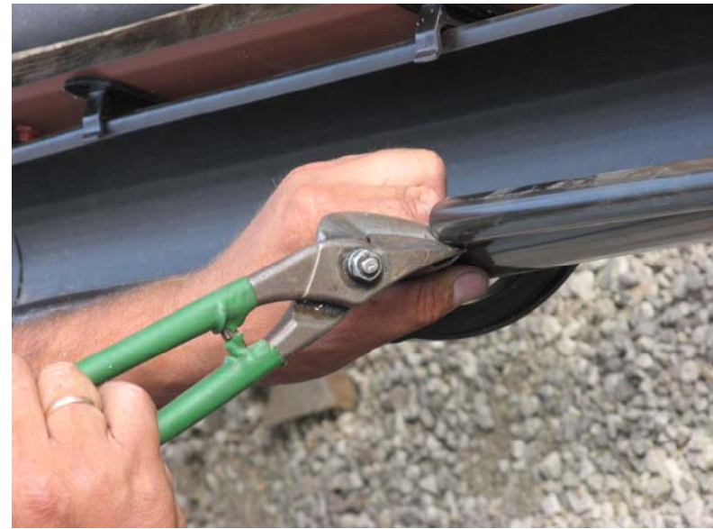
Рис. 53. Подрезание желобов
