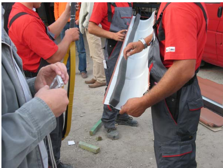
Рис.42. Наклейка универсального уплотнителя
