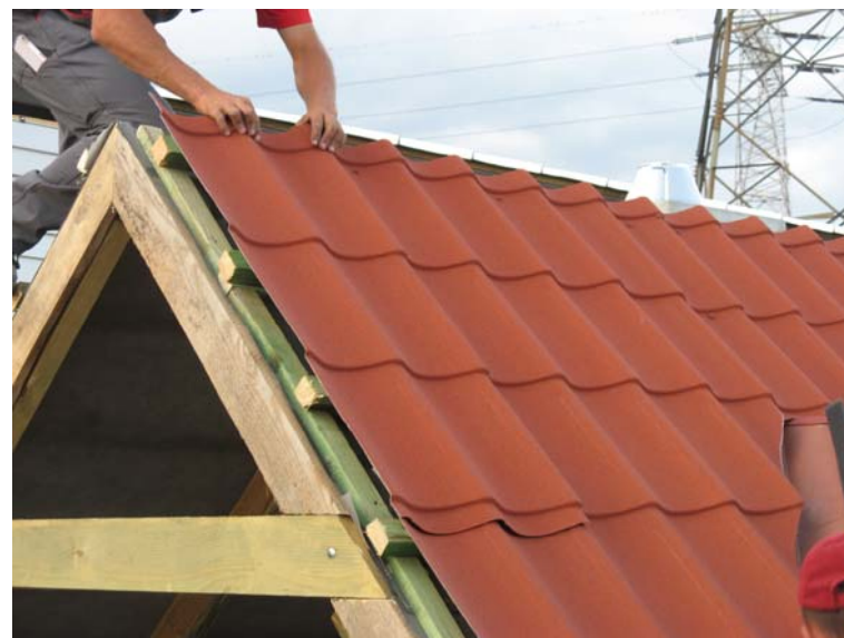
Рис.38. Окончательное крепление последнего листа на скате
