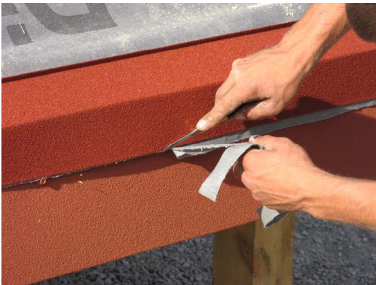
Рис.22. Подрезание краев супердиффузионной мембраны
