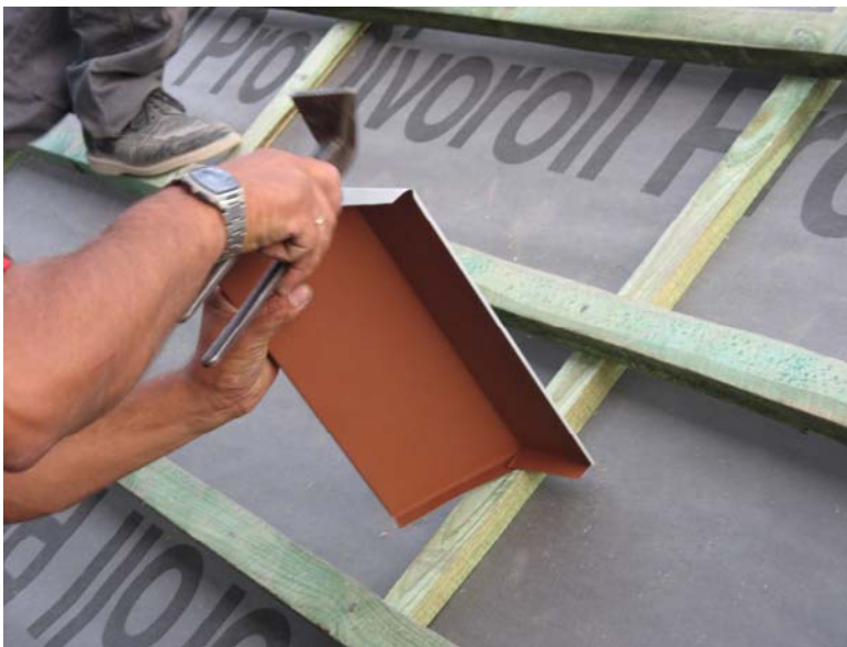
Рис. 64. Изготовление нижней планки фартука
