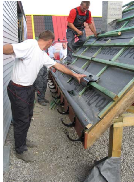
Рис. 51. Установка промежуточных кронштейнов
