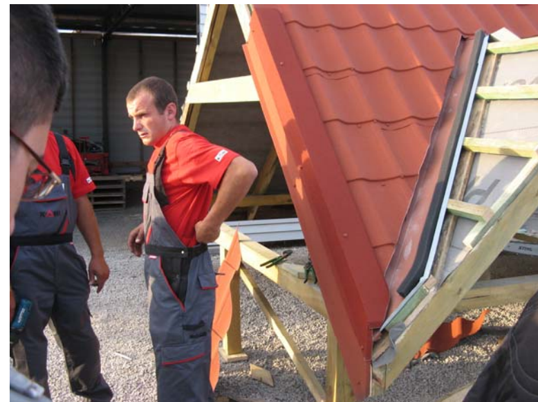
Рис.48. Крепление планки ветрозащиты к ветровой доске
