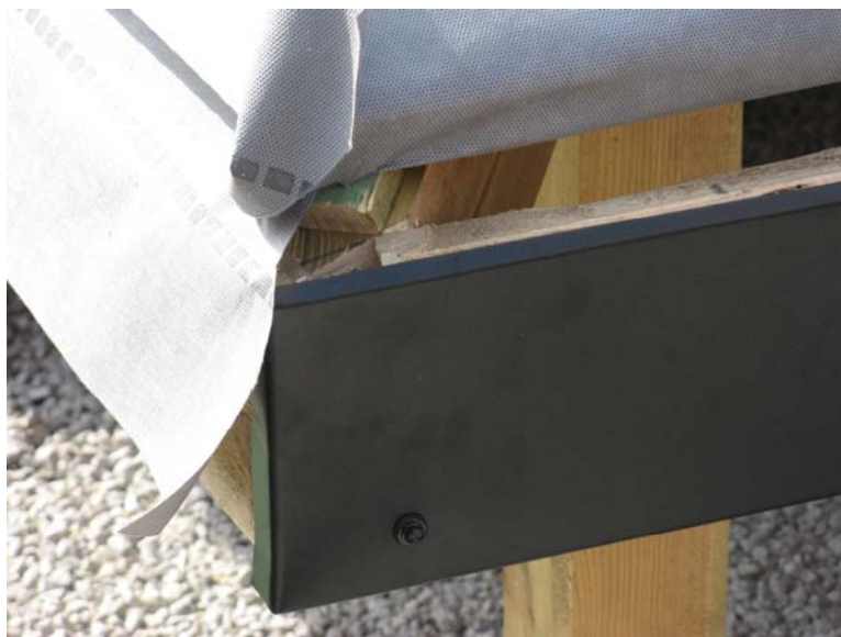
Рис. 56. Подготовка лобовой доски
