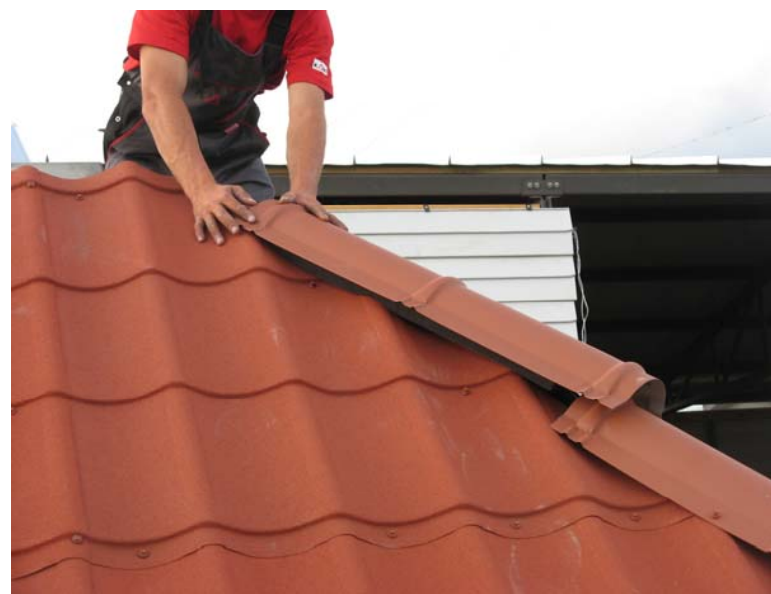
Рис.45. Монтаж смежных планок по длине конька
