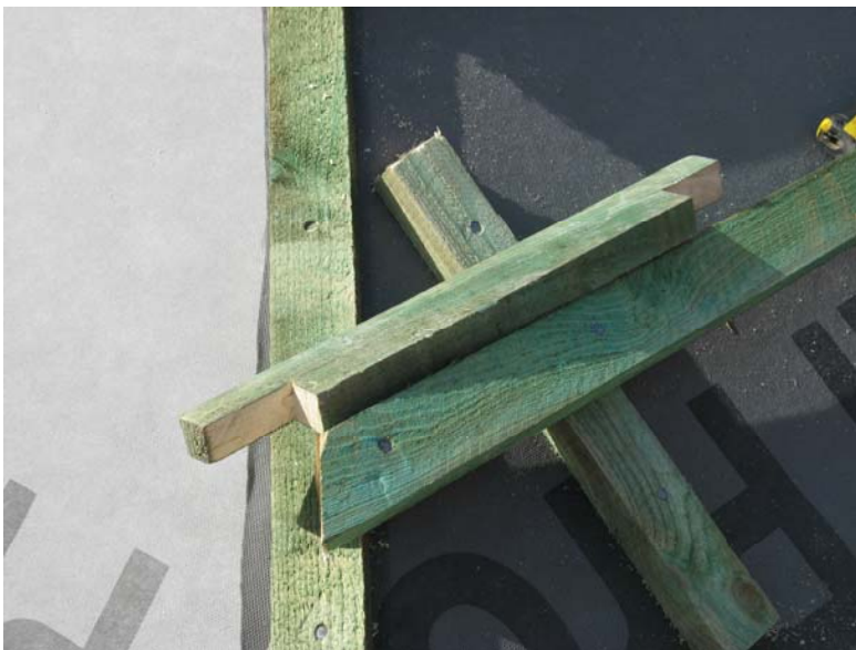
Рис.13. Шаблон для монтажа рядовых реек обрешетки
