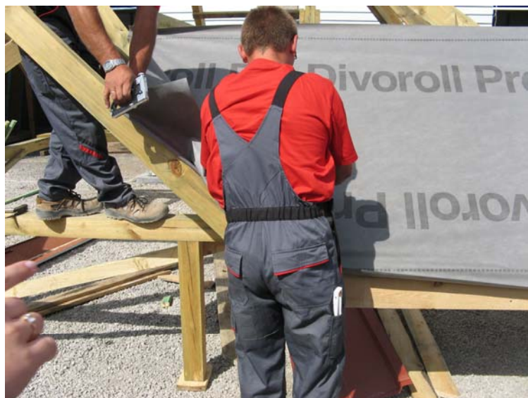
Рис.9. Раскладка полотнищ мембраны на поверхности ската
