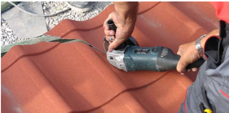
Рис.30. Подрезка второго листа металлочерепицы
