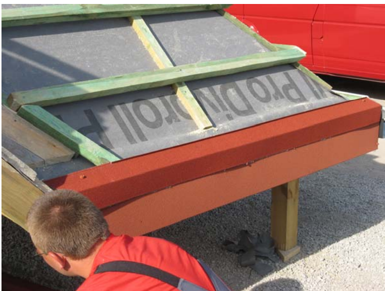
Рис.23. Расположение карнизной планки по длине карниза
