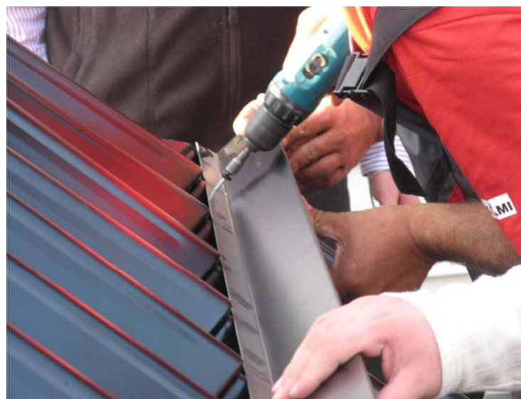
Рис. 61. Крепление планки снегоуловителя к обрешетке
