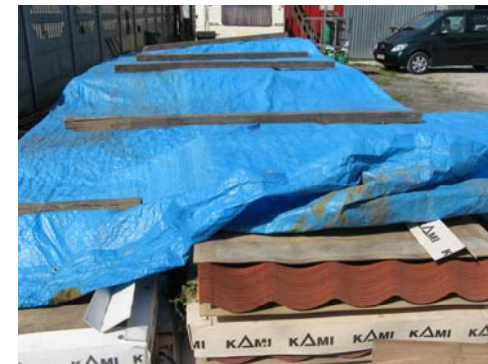
Рис.7. Хранение листов металлочерепицы на открытом воздухе
