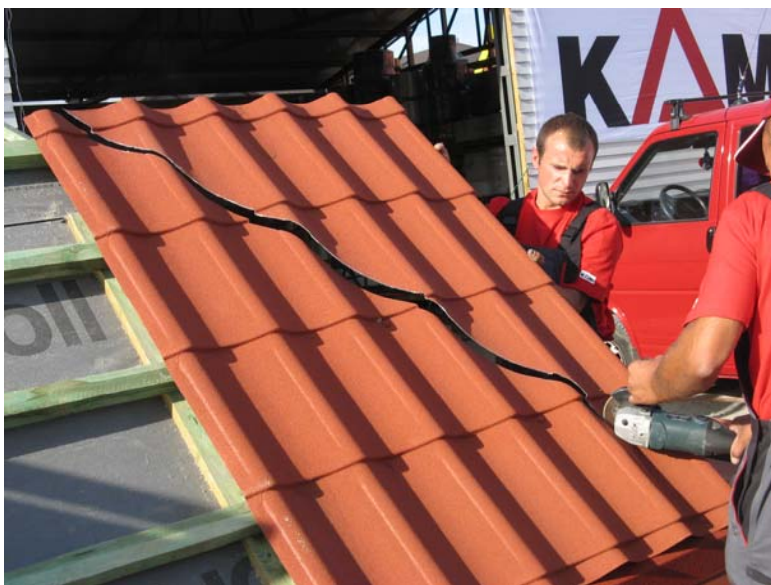
Рис.26. Подрезание первого листа металлочерепицы
