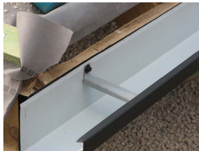
Рис. 58. Крепление планки желоба распорками
