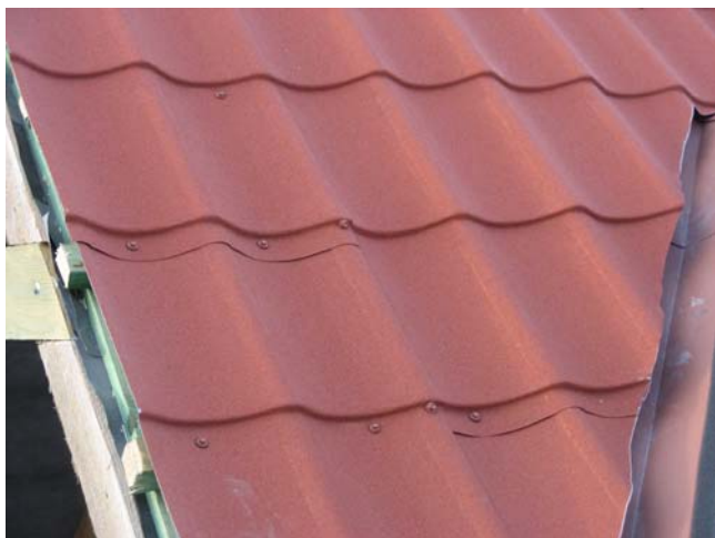
Рис.39. Обрезанные листы металлочерепицы на ендове
