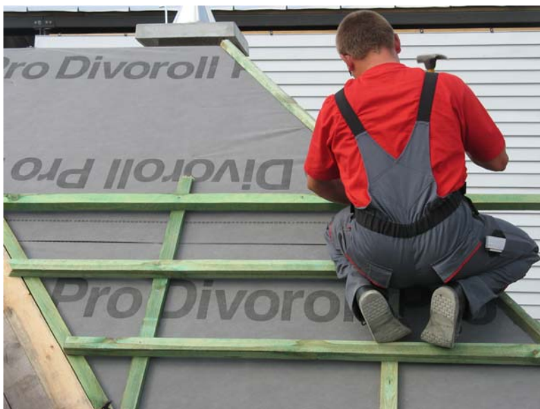
Рис.14. Расположение реек обрешетки на поверхностях скатов
