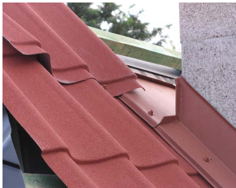
Рис. 70. Напуск металлочерепицы на верхнюю планку фартука
