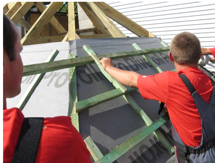
Рис.12. Монтаж рядовых реек обрешетки
