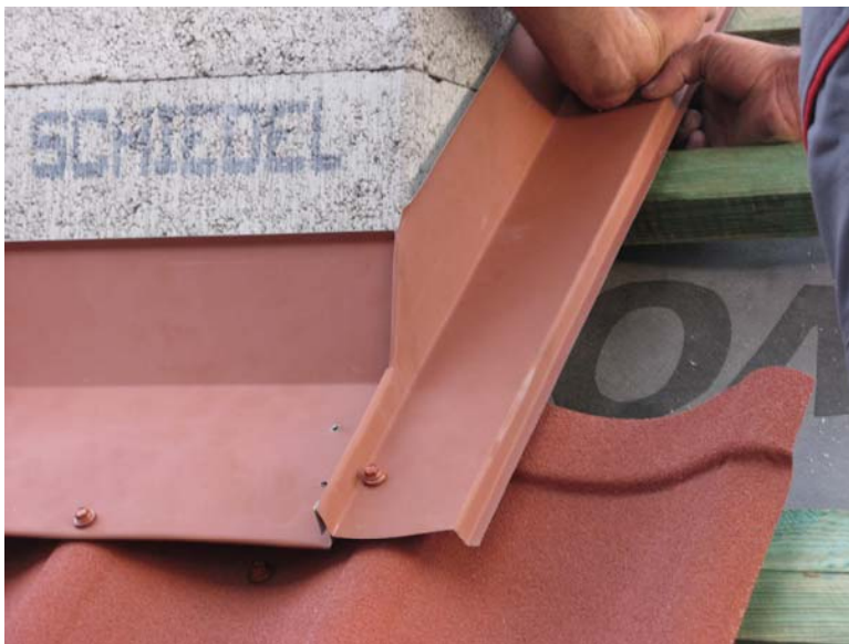
Рис. 66. Определение размеров боковой планки фартука
